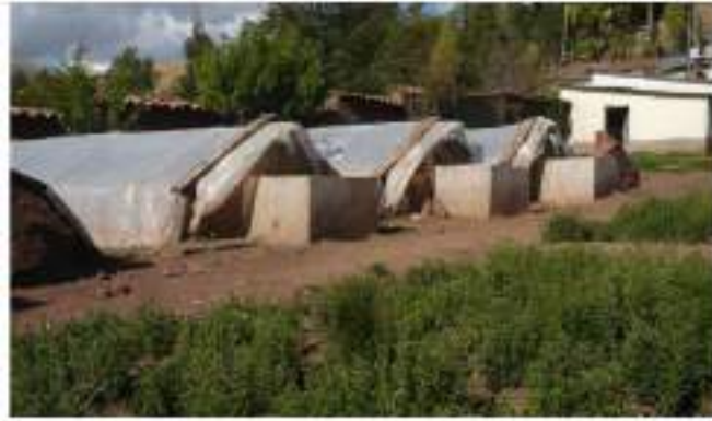
Figura 4.23. Biodigestores de planta piloto en Cusco
