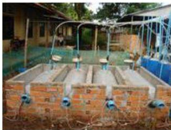
Figura 4.5 Biodigestores con agitación mediante cuerda
