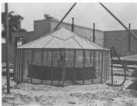
Figura 4.18. Estructura de invernadero sobre un biodigestor de domo flotante de 80 m 3 en India
