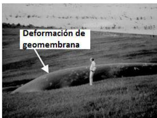
Figura 4.13 Deformación de una geomembrana debido a los gases producidos en un vertedero
