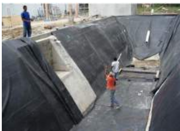
Figura 2.27. Laguna de hormigón cubierta con membrana
