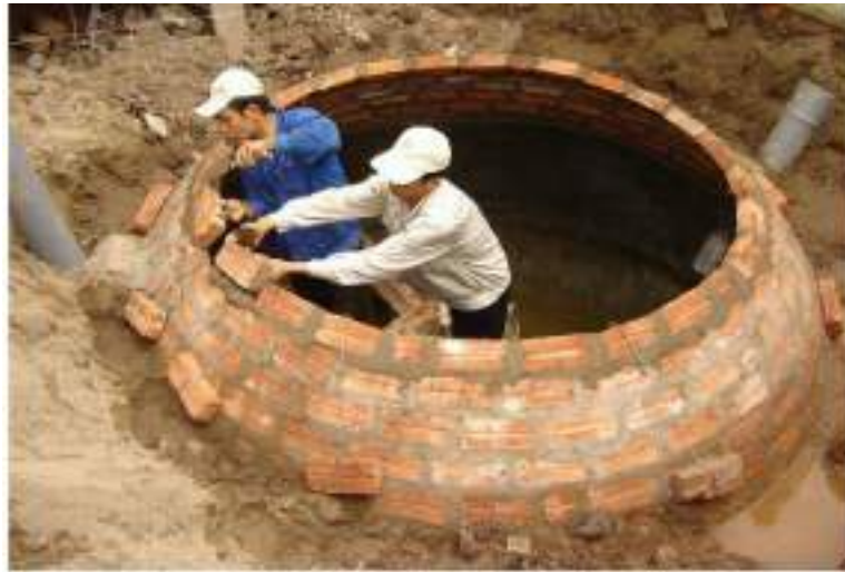
Figura 2.9. Construcción de biodigestor tipo chino en Vietnam
