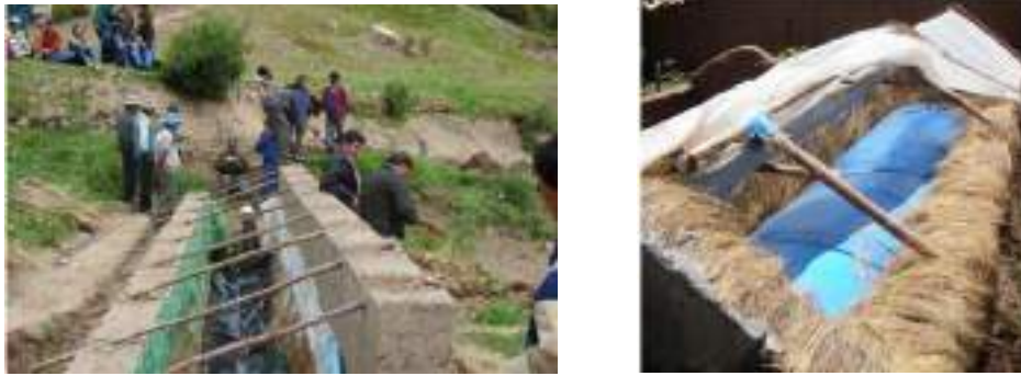
Figura 4.19 Estructura de invernadero sobre biodigestores tubulares Fuente: Martí Herrero (2008) izquierda y Weatherford (2010) derecha
