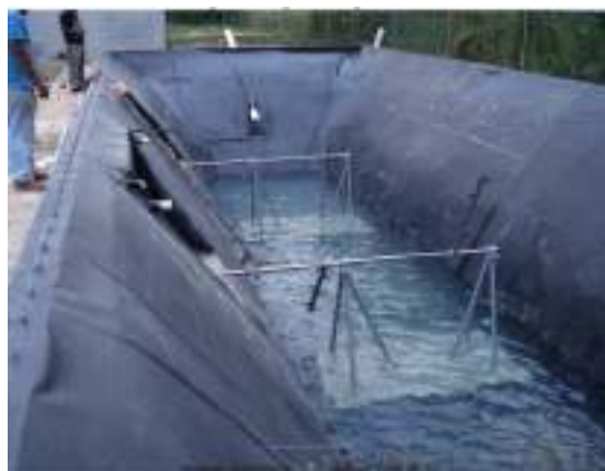
Figura 2.29. Laguna de biodigestor terminada (con cubierta, tuberías de alimentación y descarga, y agitadores)
