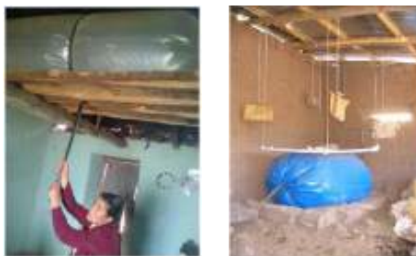
Figura 4.48. Reservorios de biogás con mecanismos para mantener la presión uniforme
