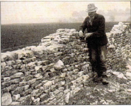
MUROS LEVANTADOS EN ZONAS DE PIEDRA POBRE Cuando la piedra local viene en forma de bloques grandes y difíciles de romper, tal como sucedía en el terreno que yo cultivaba cuando vivía en Gales, los muros suelen ser bajos, y sin ningún tipo de refuerzos, necesitando reparaciones constantes.
