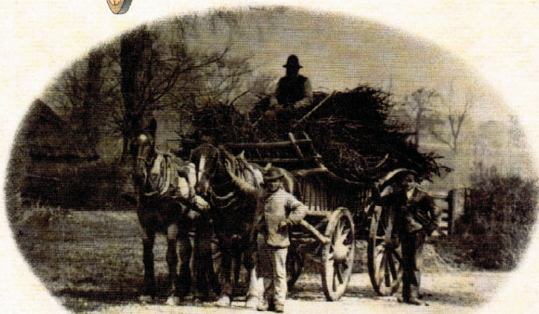
EL CARROMATO DE CARGA El carromato de carga es el resultado final de toda una larga experiencia en la fabricación de carruajes. En este ejemplo, de Oxfordshire, que es de finales del siglo pasado, se puede observar que los detalles en hierro y madera son mucho más simples que los del carro de arqueado.
